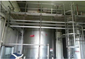
Thailand Nestle Plant Project 泰国雀巢工厂项目
