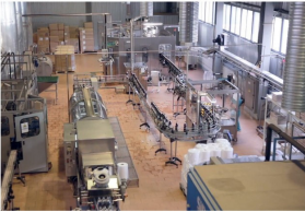
Beverage Processing Plant Project 饮料加工厂项目
